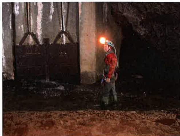
Le barrage Cremieux sur la Sorgues souterraine
