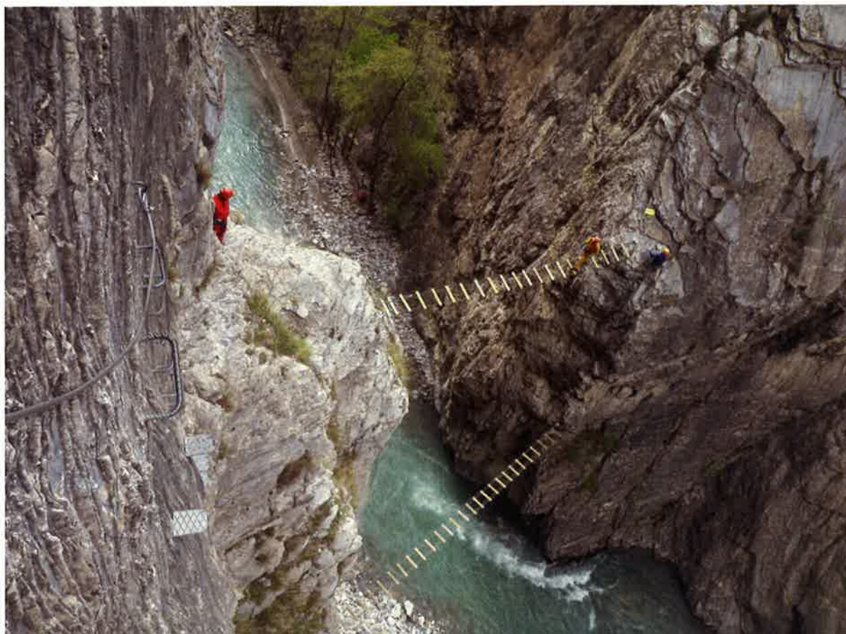
Via Ferrata de La Durance équipée de passerelles reliant les 2 rives
