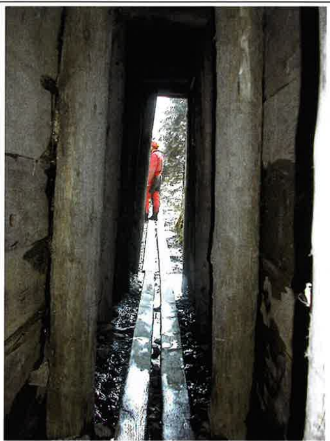
mine du Chêne : voies pour les chiens de mine
